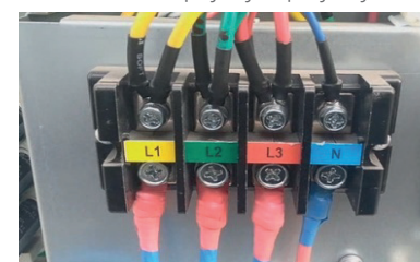
Terminali za napajanje spoljne jedinice
